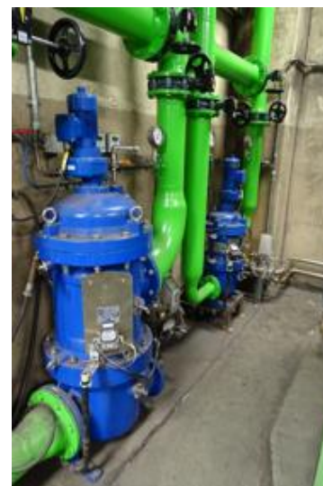
Automatikfilter aquaBoll® im Kühlprozess
