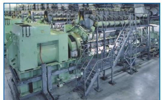
TOPO. Visual de planta de energia em Salvador, Brasil. CENTRO. Boll 6.46 Filtro Automático. ACIMA: Sala de turbinas com energia Diesel típica.
