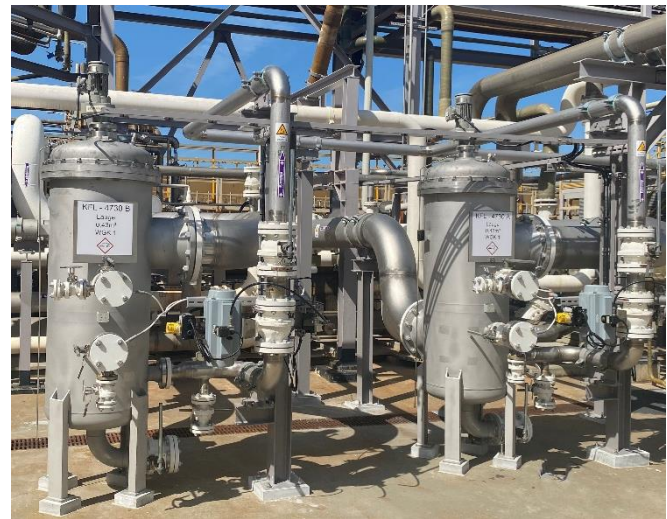
BOLLFILTER Automatik Typ 6.18.2 DN300
