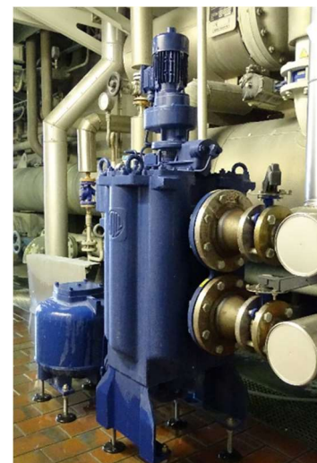
Fig. 3: BOLLFILTER automático modelo 6.64 DN125
