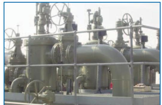
SUPERIOR. Estación de bombeo de una refinería de combustible de aviación. CENTRO Y ARRIBA. Sistema de filtración automática Boll formado por dos filtros de servicio y uno de reserva Boll 6.18.
