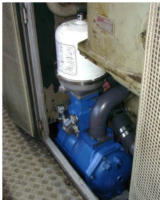
BOLLFILTER Automático Tipo 6.46 DN 100 en uso
