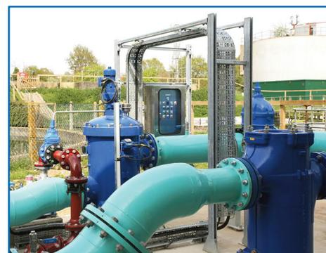
SUPERIOR. Planta depuradora de Cranleigh donde aparece el sistema NSAF detrás de uno de los tanques de sedimentación. CENTRO. Filtro Bollfilter 6.18 SUC con bomba auxiliar de retrolavado. ARRIBA. Sistema Bollfilter de protección de NSAF compuesto por filtro automático, filtro manual de derivación y panel de control.
