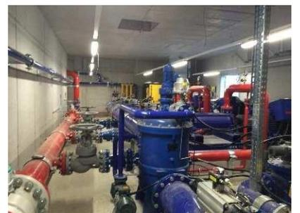
Imagen 3: Sistema de filtración en la estación de bombeo.
