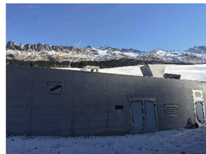
Foto 1: Vista exterior da estação da bomba
