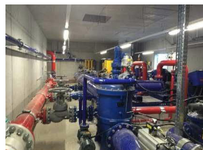
Foto 3: Sistema de filtro na estação da bomba
