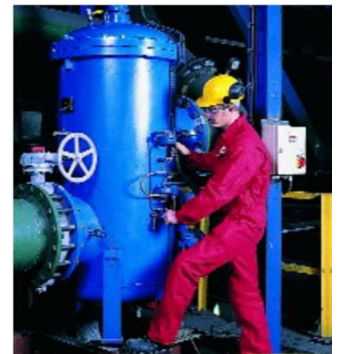
Engenheiro de Campo BOLLFILTER, realizando uma manutenção de rotina.
