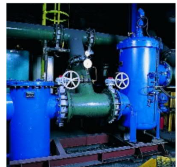
Instalação do BOLLFILTER Automático Tipo 6.18
