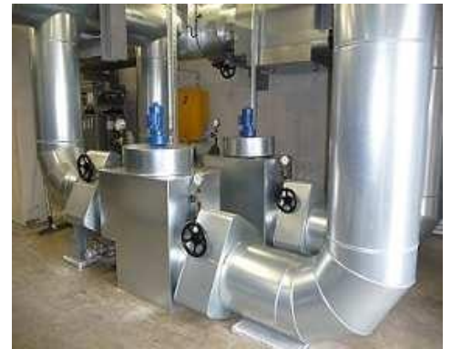
Filtro em operação paralela, com isolamento
