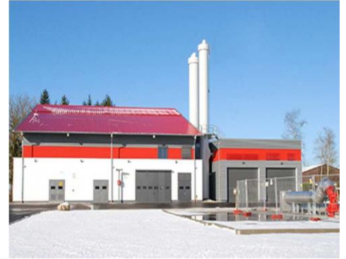
Planta de aquecimento Ismaning
