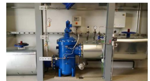
Filtro em operação
