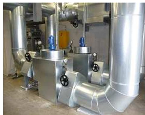
Filter im Parallelbetrieb, mit Isolierung
