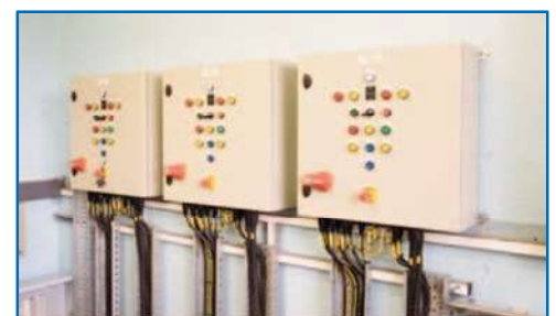
TOPO. Sistema de ultrafiltração contínua Memcor típico. CENTRO. Sistema de filtração Bollfilter composto por três filtros automáticos autolimpantes SUC 6.18. ACIMA. Cada filtro tem um sistema de controle com alarme ligado a uma central de monitoramento remoto.
