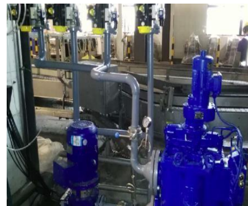
BOLLFILTER Automático Tipo 6.64 en la máquina de lavado de botellas
