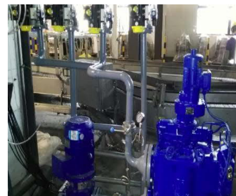
BOLLFILTER Automático Tipo 6.64 na máquina de lavagem de garrafas
