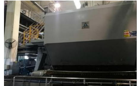
BOLLFILTER instalado no GLM2 BWM de garrafa 2 Linha
